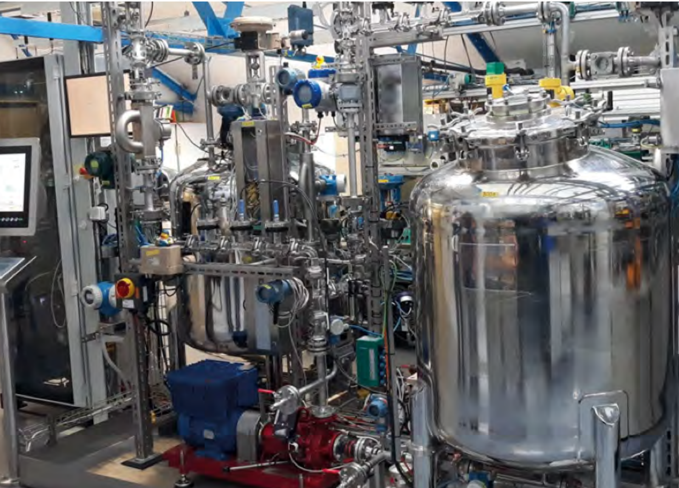
Abbildung 2: Demoanlage der IGR e.V. am Standort Frankfurt Höchst
